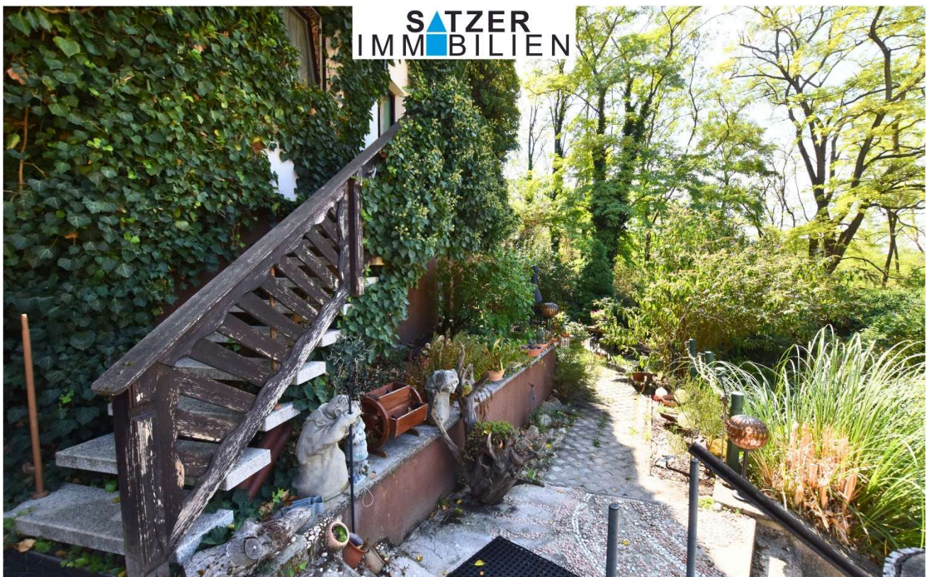
Stiege zum straßenseitigen Eingang
